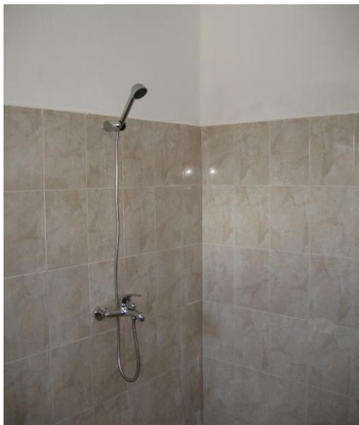
Фиг. 13. Ремонтиран санитарен възел
