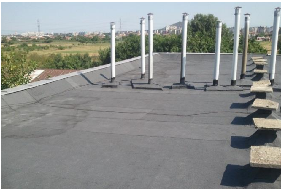
Фиг. 14. Ремонтиран покрив
